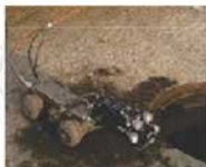
TV inspekcija cevovoda (kamerom).
